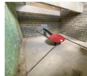
Le silo à stockage doit être installé dans un lieu sec et étanche, sans conduit d'installation électrique et sans passage de conduite d'eau. L'alimentation de la chaudière à granulés se fait par un système automatisé qui alimente la chaudière en fonction des besoins du bâtiment. Des ballons eau chaude seraient installés pour éviter les courts cycles de la chaudière.
